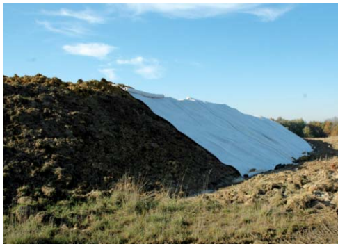
A szigetelő anyag terítése
